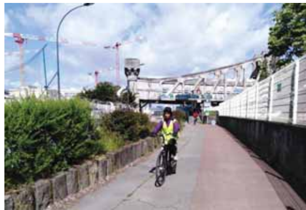
5. Quai Auguste Deshaies à Ivry (photo Ph. Ungerer)
