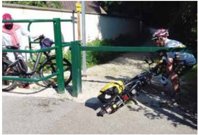
5. Chicane inadaptée côté Bar-sur-Seine (photo Ch. Jacob)
