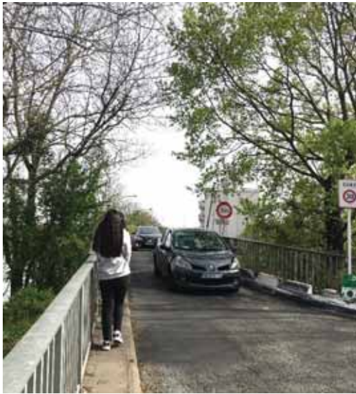
3. Franchissement d'une darse à Villeneuve-le-Roi (ph. A. Duguet) : passage très étroit sur un pont à circulation alternée (dont bus).
