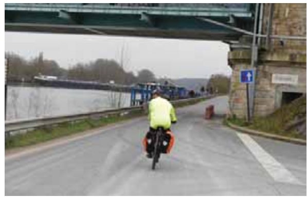
13. La Rochette : passage sous la voie ferrée (photo E. Marchandise)
