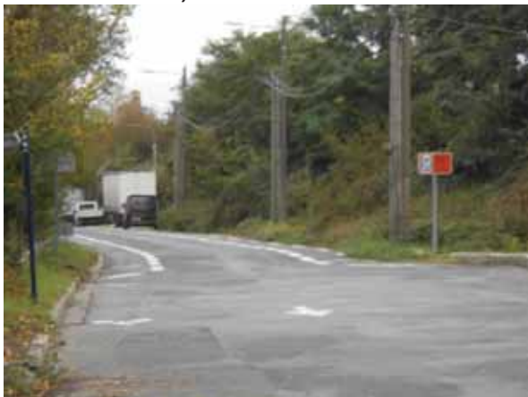
15. Dammarie-lès-Lys : voirie traitée en « Chaucidou » (photo M. Robert)
