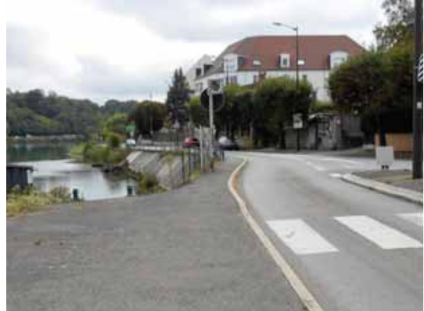
7. RD 326 à Melun : emplacement possible de l'amorce d'un futur ponton, à réaliser (photo M. Robert)
