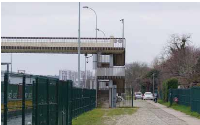
6. Ablon-sur-Seine : passerelle de l'écluse (photo A. Duguet)
