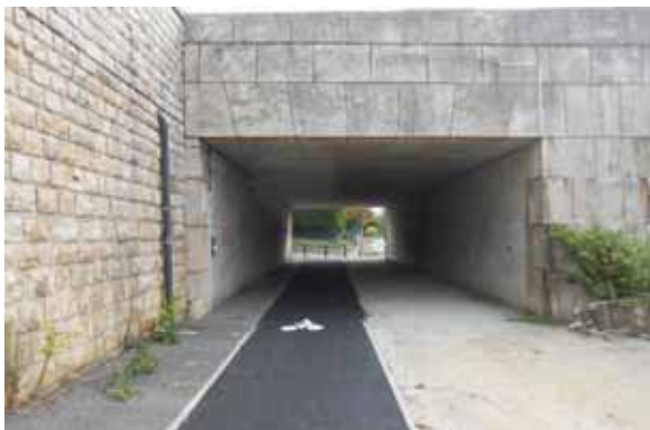
3. Passage sous le pont de franchissement de la Seine côté Ouest (photo M. Robert)
