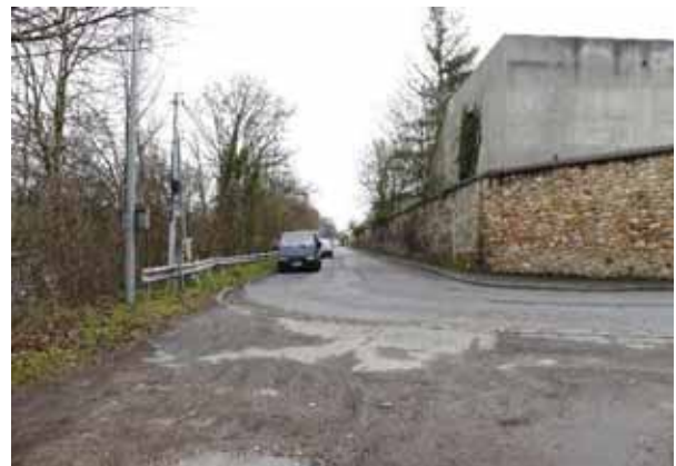
5. Ponthierry : arrivée sur une voirie circulée (photo E. Marchandise)
