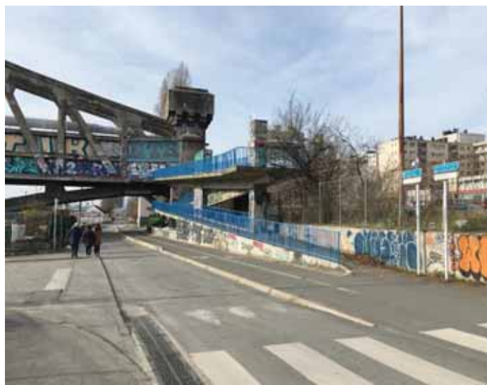
4. Franchissement de la Seine par la passerelle des câbles (photo A. Duguet)
