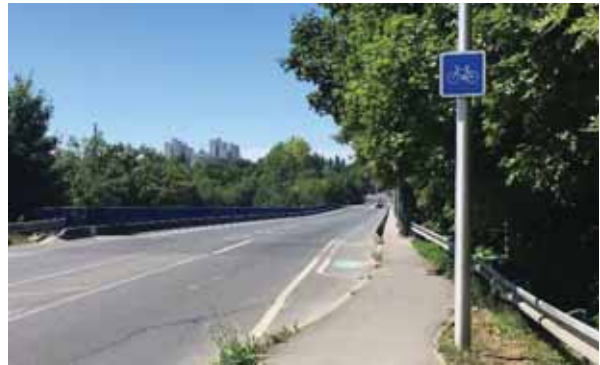
6. Pont du Général Patton, avec des bandes cyclables sur le côté (photo A. Duguet)
