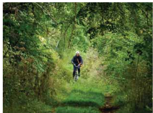
13. Sentier non revêtu à l'Est de la passerelle à reconstruire (photo E. Marchandise)
