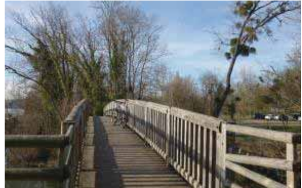
4. Draveil : Franchissement de l'accès à l'Etang des Mazières (photo B. Carrouée)
