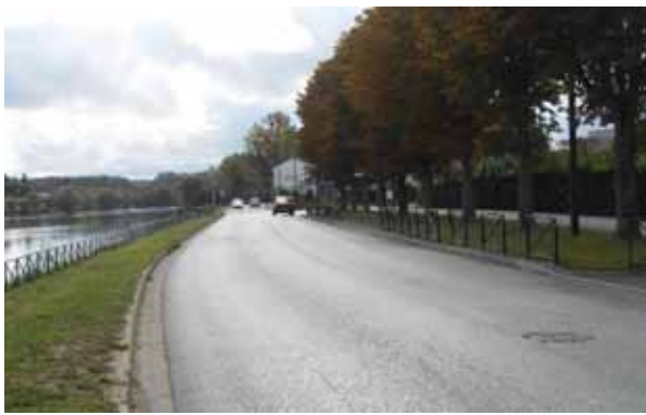
12. RD 326 à Melun (quai Joffre) entre la piscine olympique Laure Manaudou et la salle des fêtes L'Escale (voie verte sous les arbres à droite) (photo M. Robert)
