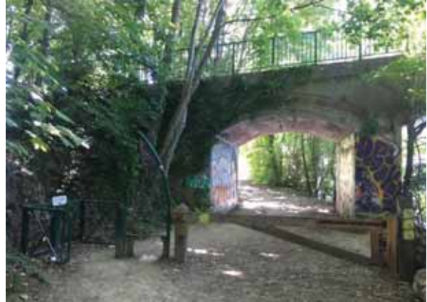
4. Etiolles : ancien pont d'Evry (photo B. Carrouée)
