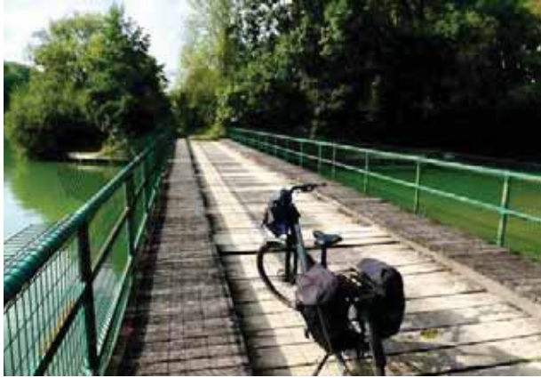
9. Quatrième passerelle sur le chemin de halage (photo Ch. Jacob)
