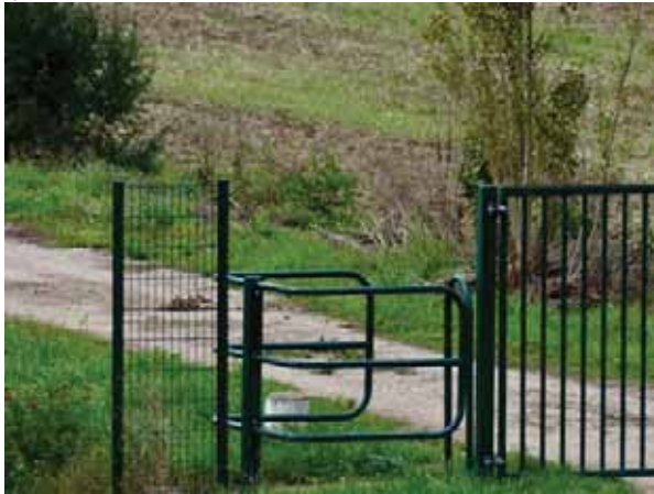
11. Protection anti-voitures inadaptée à La Grande Paroisse (photo E. Marchandise)
