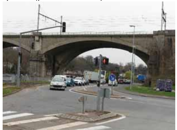
16. Passage sous le pont SNCF à aménager (photo E. Marchandise).
