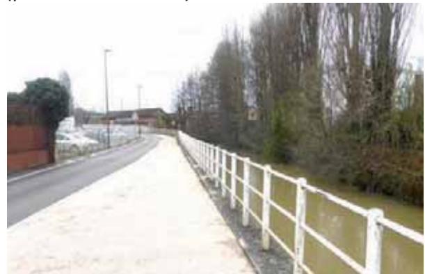
4. Passage le long de la Seine (photo M. Delmotte)
