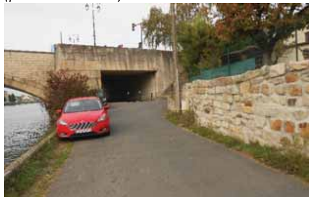
4. Passage sous le pont de franchissement de la Seine côté Est (photo M. Robert)
