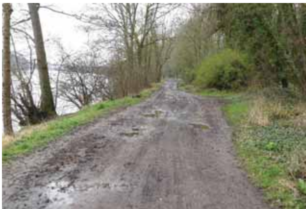
4. Revêtement à refaire à l'Est du Monument Patton (photo E. Marchandise)
