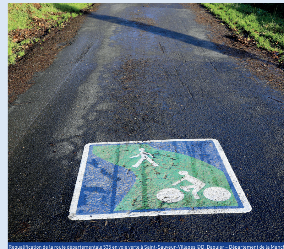
Requalification de la route départementale 535 en voie verte à Saint-Sauveur-Villages ©D. Daguier - Département de la Manche
