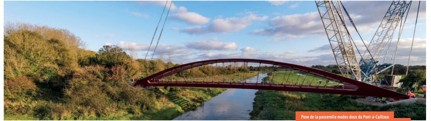
Pose de la passerelle modes doux du Pont-à-Caillox ©Syndicat mixte Baie de Somme - Grand Littoral Picard/S. Poix
