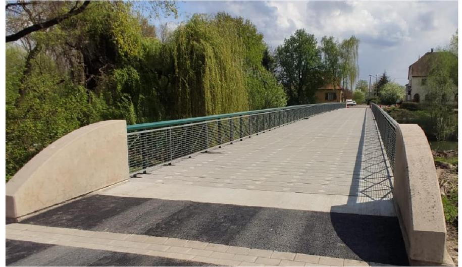
Gerstheim - Pont ouvert aux VL et aux cycles – remplacement platelage bois par des lames BFUP
