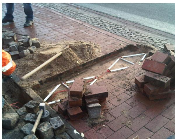
Figure 3 Boucles inductives sous pavage, source : Eco-Counter
