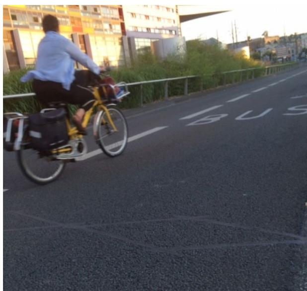
**Figure 8 Boucles inductives sur voie partagée (vélos et bus), source : Eco-Counter**
