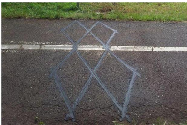
Figure 1 Boucles inductives sur asphalte, source : Eco-Counter
