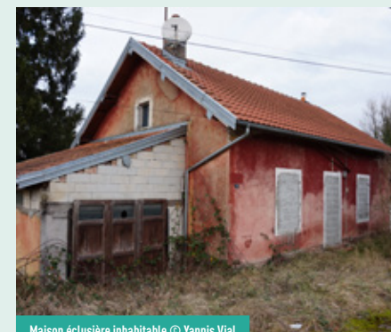
Maison éclusière inhabitable © Yannis Vial
