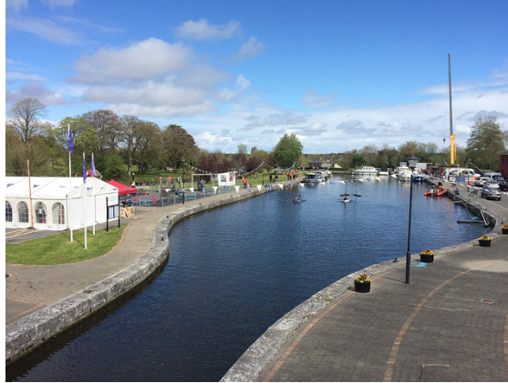
Restauration du Canal royal 140 km de navigation supplémentaire
