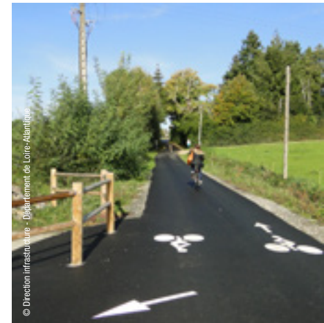
Liaison entre l'agglomération nantaise et le canal de Nantes à Brest - Sucé-sur-Erdre
