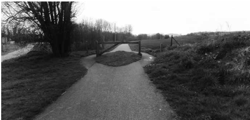
Piste de la vallée de l'Epte revêtue d'un enrobé (en plus on peut y mettre du marquage ce qui n'est pas possible sur les routes non revêtues)
